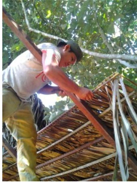
On met une branche dans un sens puis la suivante dans l'autre sens pour avoir la pointe une fois sur 2 de chaque cote. Les pointes qui dépassent se replient pour revenir sur le toit et couvrir un peu plus et ainsi avoir un toit à peu près droit. Ainsi tout est couvert, il reste le sommet à couvrir.
