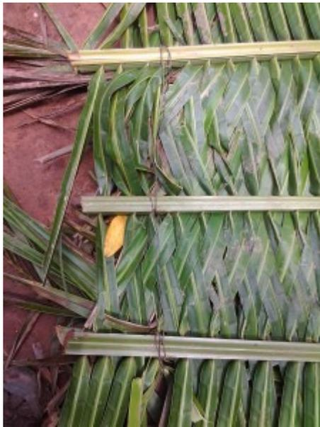
Ensuite on le pose sur la poutre centrale et on laisse dépasser la pointe pour que ca protege un peu mieux de la pluie, et on fixe le tout avec du fil de fer.
