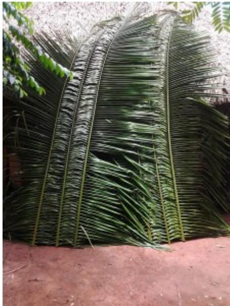
On en pose un au sol et on le recouvre avec une branche préparée comme au début dans un sens et une deuxième dans l'autre sens et on renferme avec l'autre triple branches tressée.
