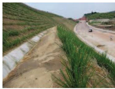
Éviter l'érosion des sols
